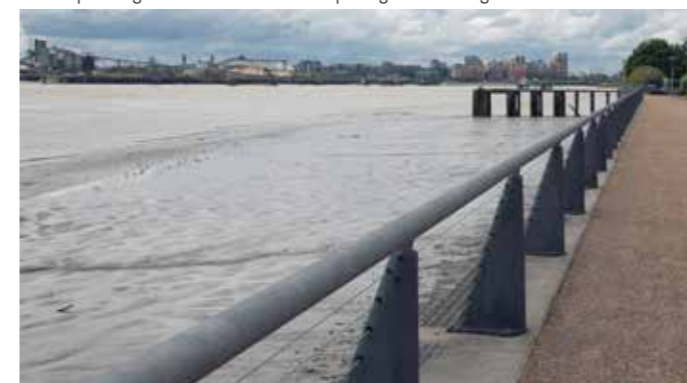
River's edge guardrail
