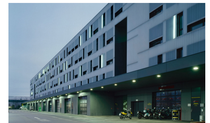
Gewerbehof Laim Bogevischs buero architekten Munich, Germany
